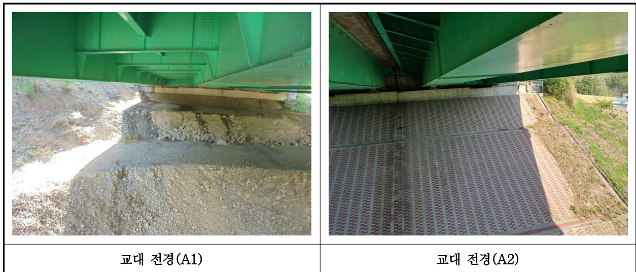
【사진 32.3.8】 교대 전경
