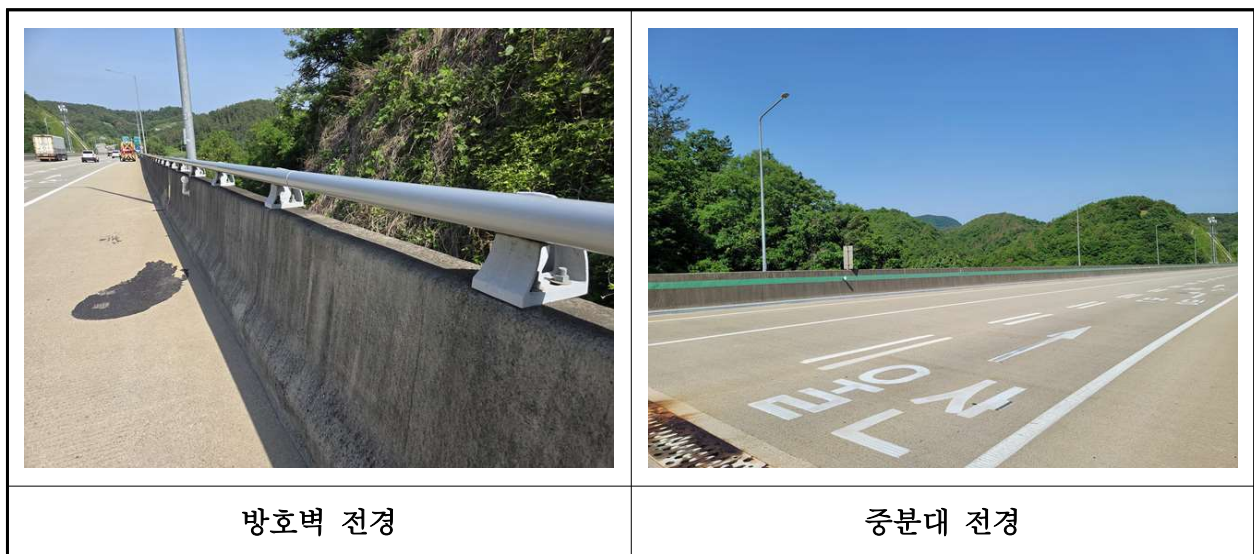
【사진 32.3.24】 방호벽 및 중분대 전경
