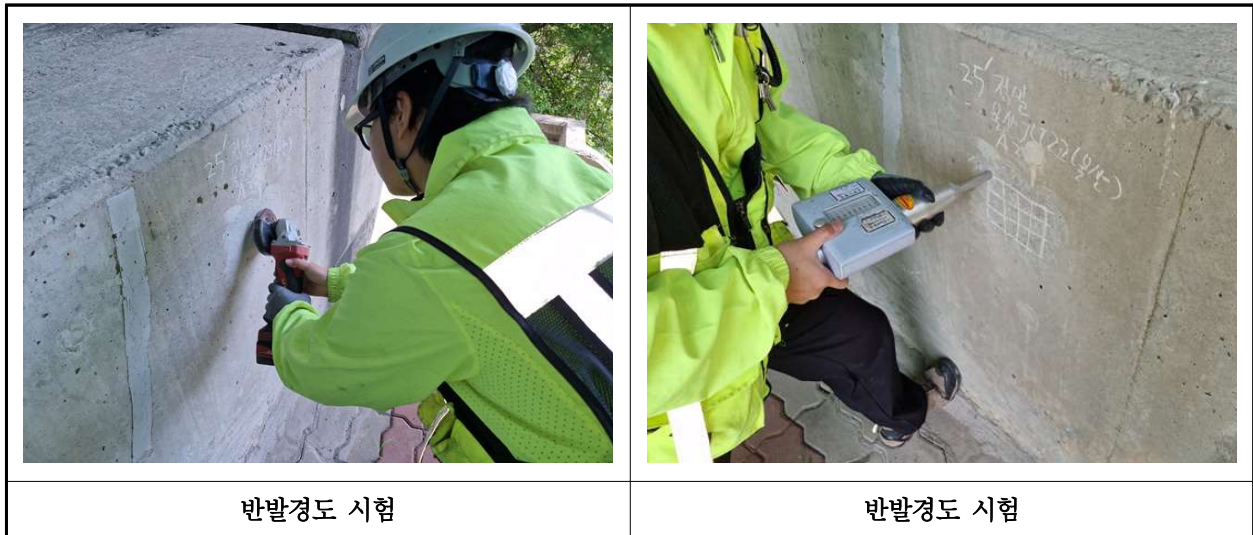
【사진 32.4.2】 반발경도시험 현장사진
