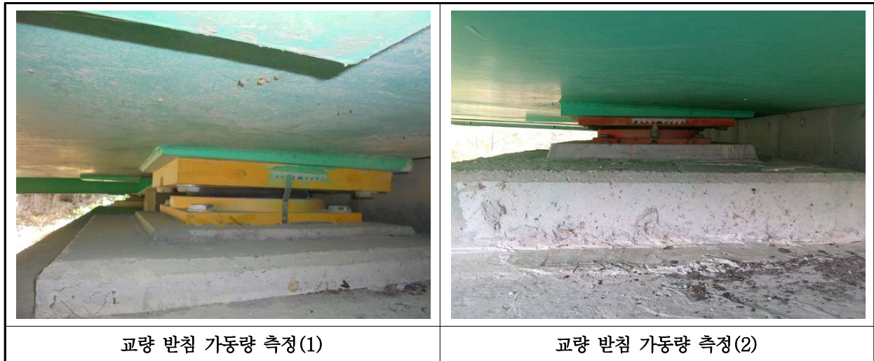
【사진 32.3.16】 교량받침 이동량 측정
