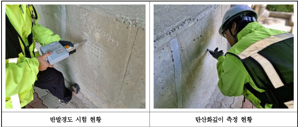
【사진 32.4.1】 콘크리트 내구성조사 현황
