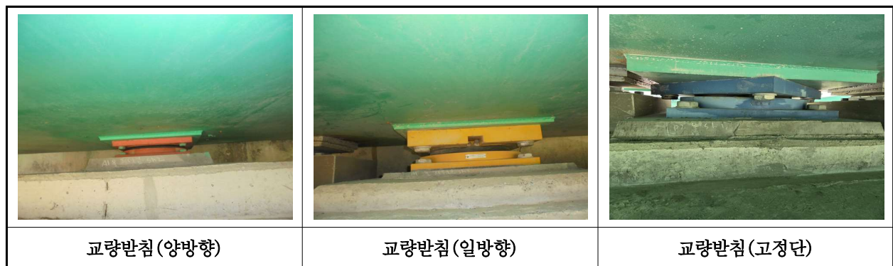
【사진 32.3.13】 교량받침 전경
