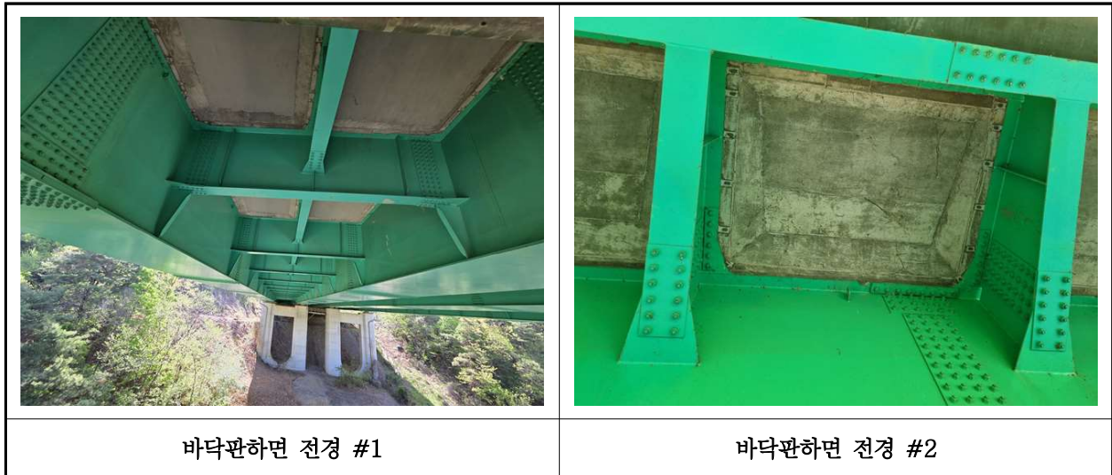
【사진 32.3.2】 바닥판하면 전경
