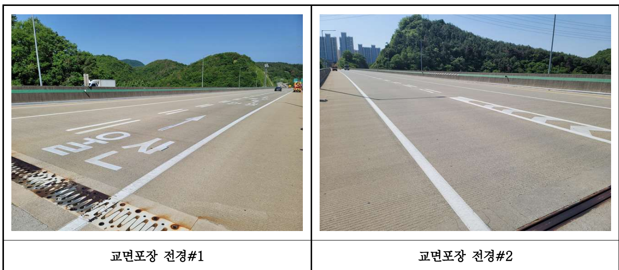
【사진 32.3.20】 교면포장 전경
