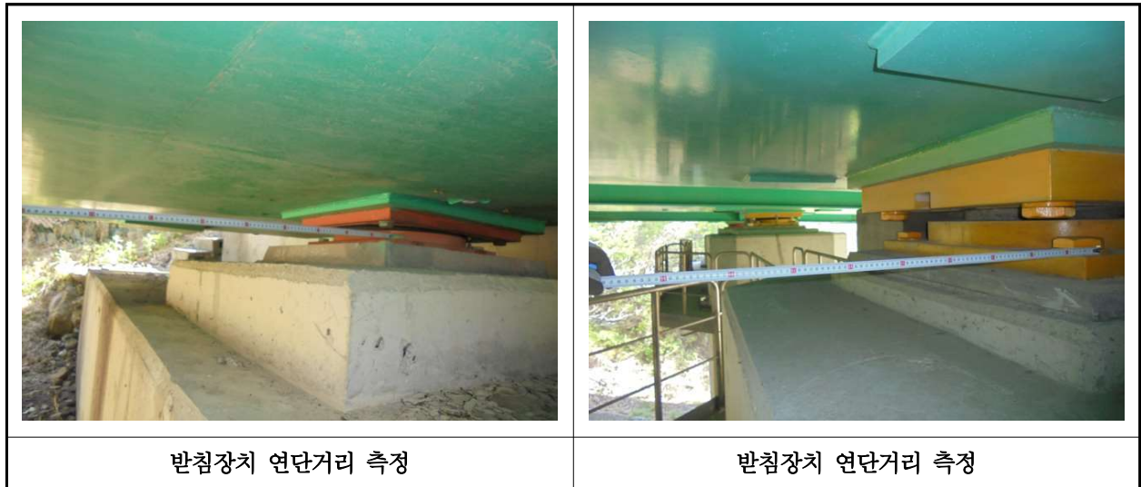
【사진 32.3.15】 교량받침장치 연단거리측정
