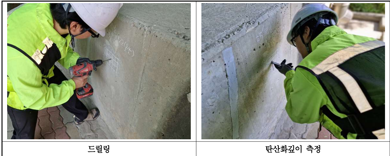
【사진 32.4.3】 탄산화 깊이 측정 현장사진
